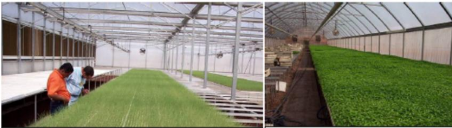
Estructura metálica, paredes húmedas y pantallas
